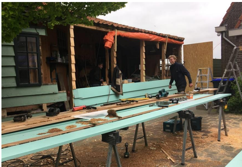
Werkzaamheden aan de zuidgevel bij De Bleeke Dood op 1 juni 2023
