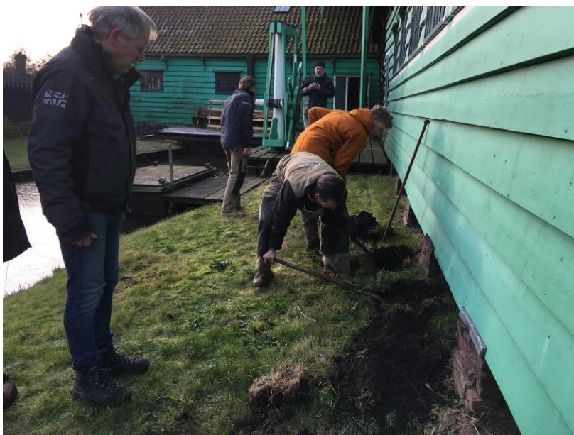
Graafwerkzaamheden bij molenschuren Het Pink i.v.m. inspectie van de fundering
